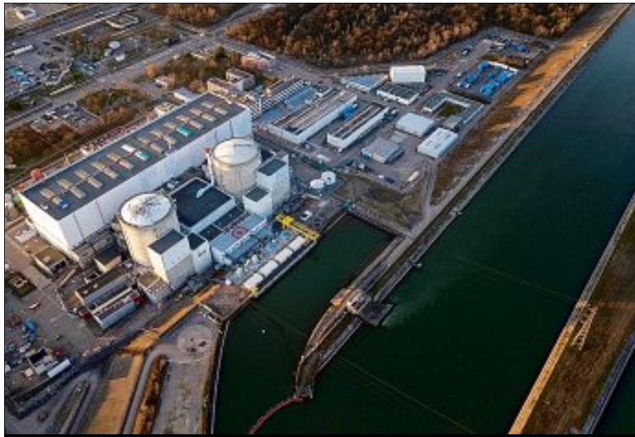
PRODUCTION. D'une puissance de 900 mégawatts chacun, les deux réacteurs de Fessenheim ont, en 2018, fourni près de 2,2 % de la production électrique en France métropolitaine. PHOTO AFP
